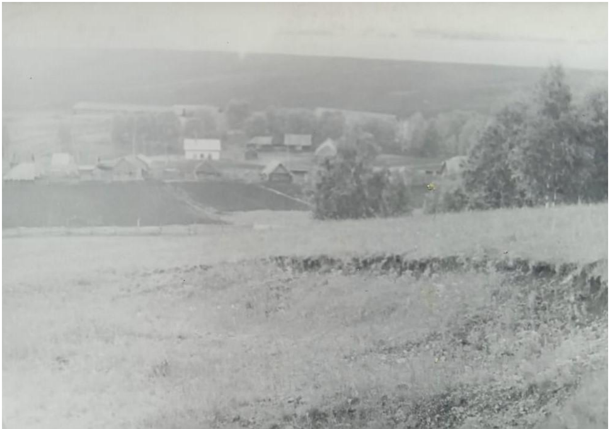
Вид на улицу Верхняя. Белый дом в центре – бывшая электростанция, позже там был магазин
